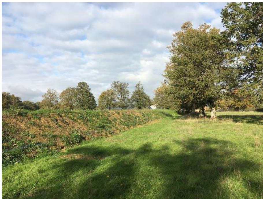
Figure 41 : Merlons en place sur la carrière (source : SEG)
